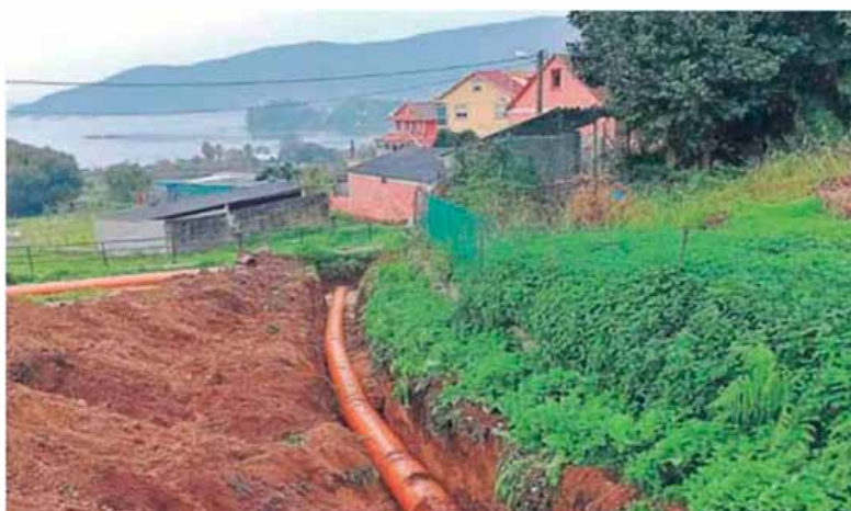
Imagen de las obras realizadas en Outeiro das Penas, en Cesantes.
