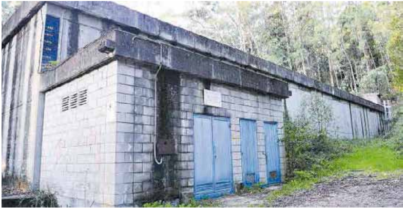
Depósito de agua de Coiro. | Gonzalo Núñez
