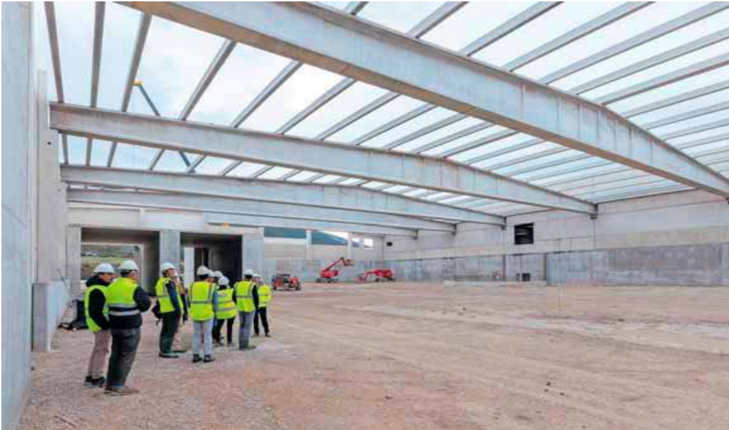
Un momento de la visita al edificio donde entrarán los camiones de recogida de residuos y depositarán la carga según su contenido.
