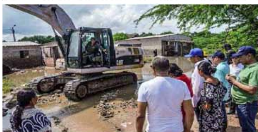
En Villa Fátima, Marbella y Las Delicias, se han instalado más de 500 metros de tubos de 12, 14 y 16 pulgadas.
